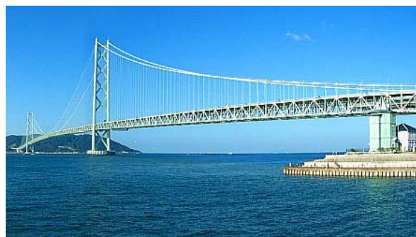
図 3. 明石海峡大橋
